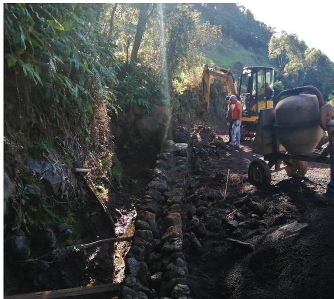
Construção de muro de contenção, prevenindo o galgamento das águas da grotta, evitando assim a destruição do caminho de circulação.
